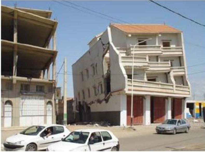
Fig. 6.1 Destruction des poteaux à cause du fonctionnement en « poteaux courts »
