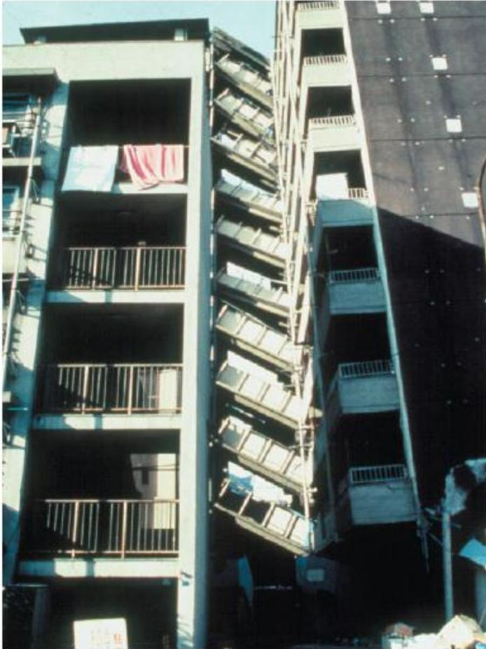
a) Destruction de passerelles due d'une part à des oscillations différentielles et, d'autre part aux dommages subis par le bâtiment de droite (séisme de Kobé, Japon, 17.1.1995)
