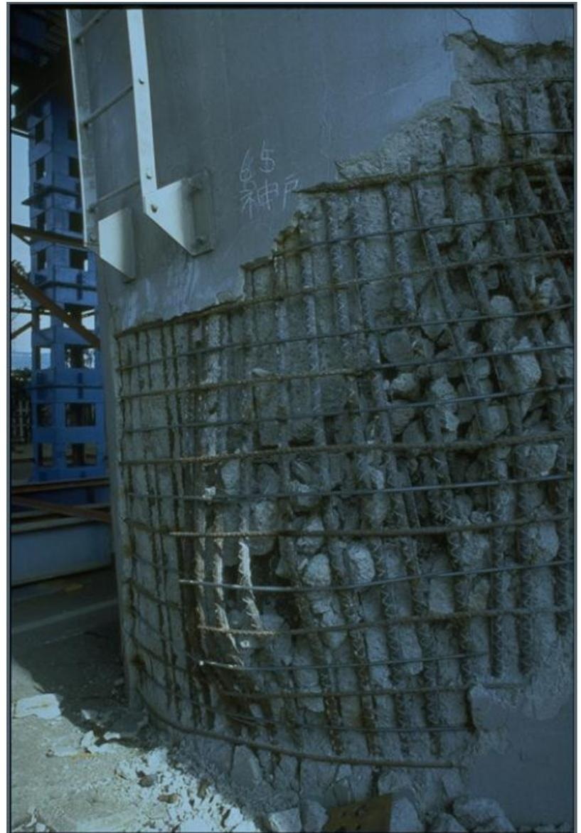
**Comportement ductile d'un béton confiné**
