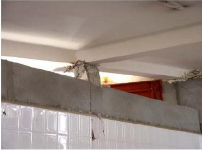
Fig. 6.3 Détail de destruction des poteaux à cause du fonctionnement en « poteaux courts »
