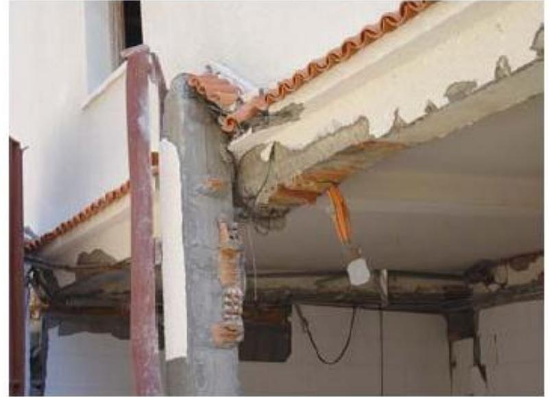
Fig. 6.2 Détail de destruction des poteaux à cause du fonctionnement en « poteaux courts »
