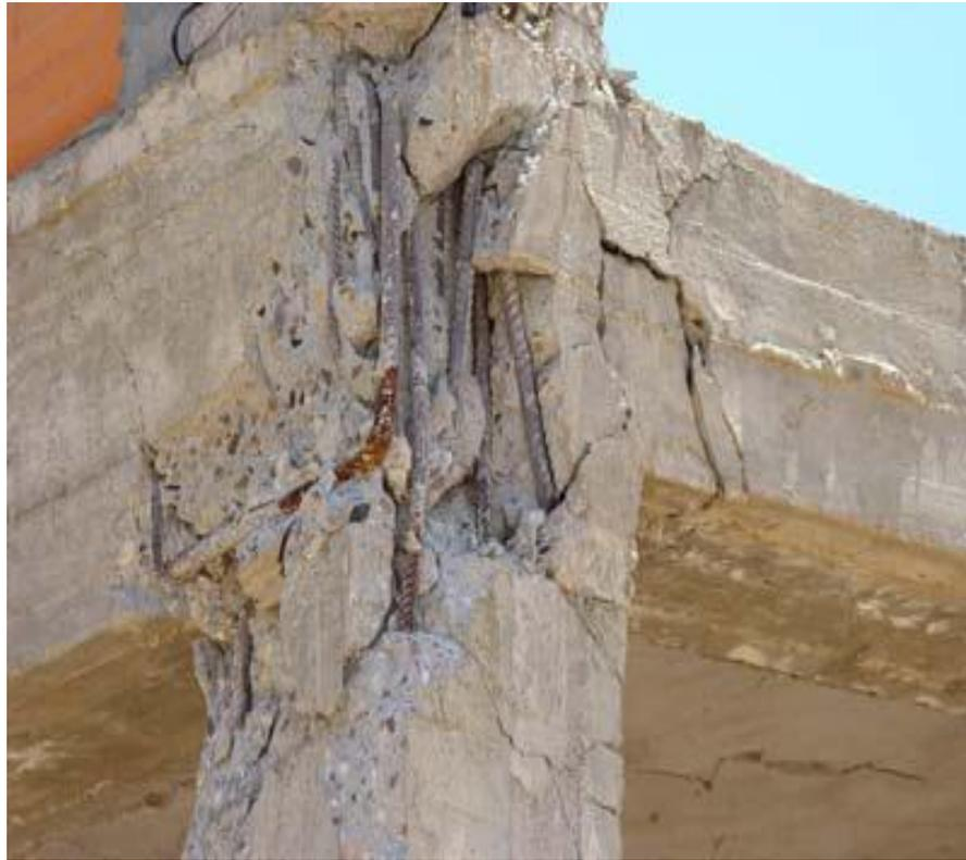
**Endommagement à cause de l'absence d'armatures transversales dans le noeud**
