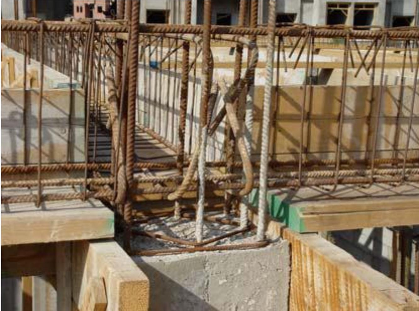
**Arrêt du coulage du poteau à environ 5 cm sous la sous face de la poutre. Absence d'armatures transversales dans le noeud.**
