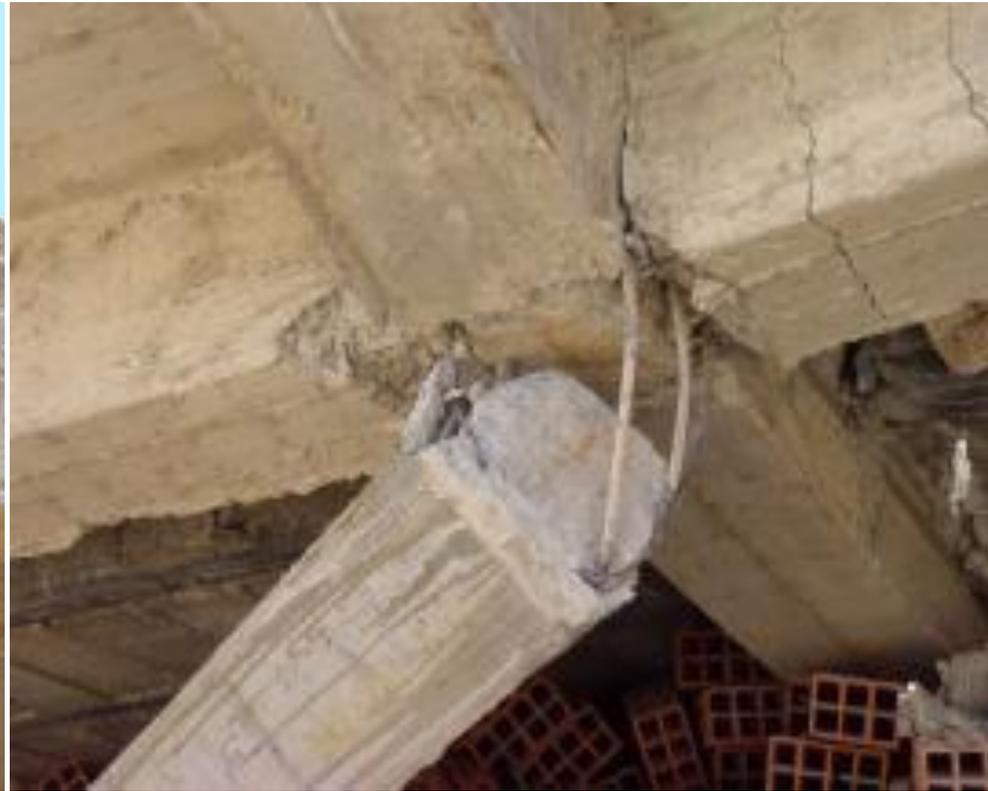
**Insuffisance d'armatures transversales, béton de mauvaise qualité, rupture au droit de la surface de reprise**
