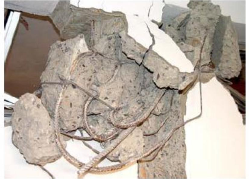
Fig. 6.4 Détail de destruction d'un poteau à cause du fonctionnement en « poteau court »
