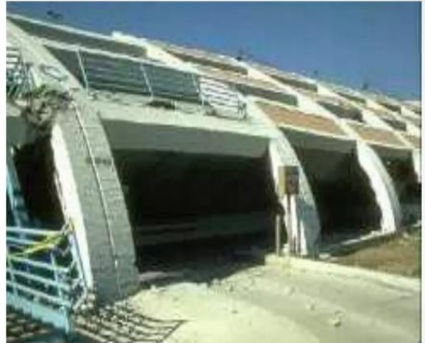
Northridge, Californie 1994 Comportement ductile. L'effondrement est dû à une erreur d'architecture et non d'exécution (effet de poteau court à l'intérieur du bâtiment),
