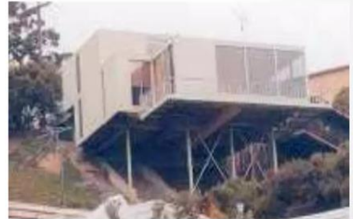
contreventement en facade
