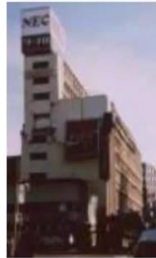
Séisme de Kobé, Japon 1995
