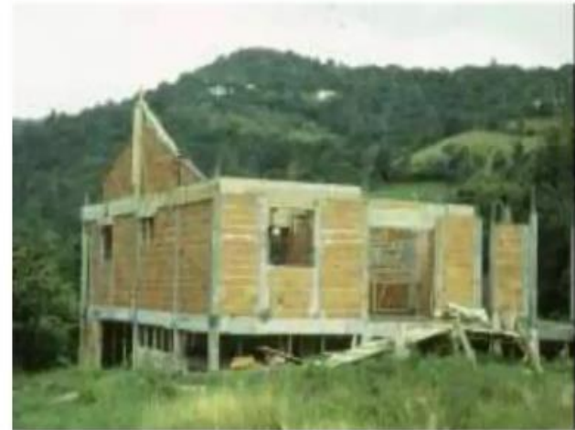
maisons en Martinique, zone de forte sismicité
