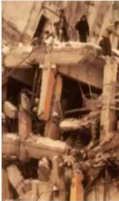
Spitak, Arménie 1988 Rupture fragile (instantanée) , la structure ne peut se déformer au delà des déformations élastiques
