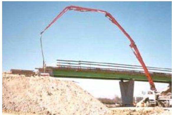
**Figure 3 :** pompage du béton
