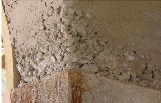
**Figure 2 :** ségrégation du béton
