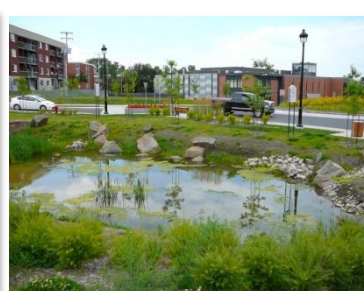
Figure 15: bassin de rétention
