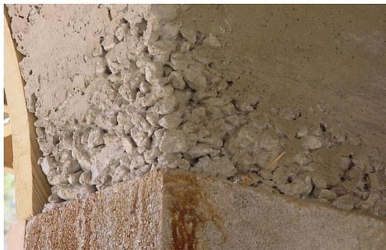
**Figure 2** : ségrégation du béton
