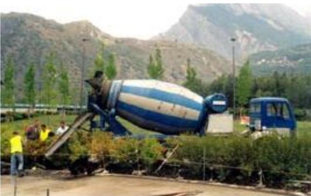
**Figure 2** : Mise en place du béton à la goulotte
