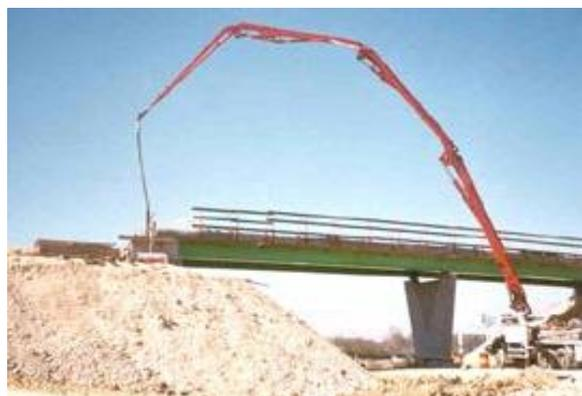
**Figure 3** : pompage du béton
