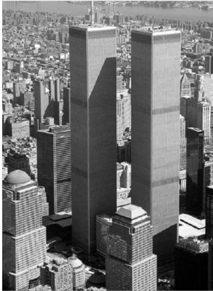
Figure (1.1) Construction du World Trade Center à New York (1973)
